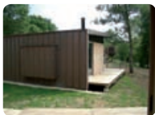
La toiture en zinc se retourne en façade Nord pour protéger l'habitat des vents froids dominants.
