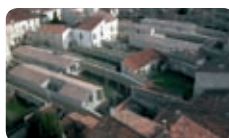
Renouveler et densifier l'existant : interventions fines de réhabilitations, démolitions partielles et constructions nouvelles, associant logements individuels et collectifs.
