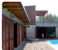
Avancée de toiture au Sud
