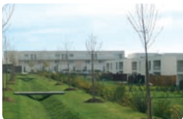
Noues enherbées pour absorber et filtrer les eaux de pluies.
