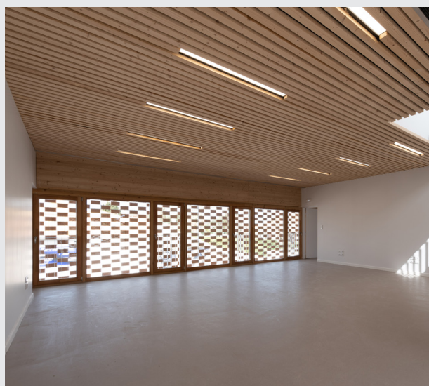
Salle de classe : plafond en carreaux de douglas et sols en linoléum (lin, poudre de bois).
