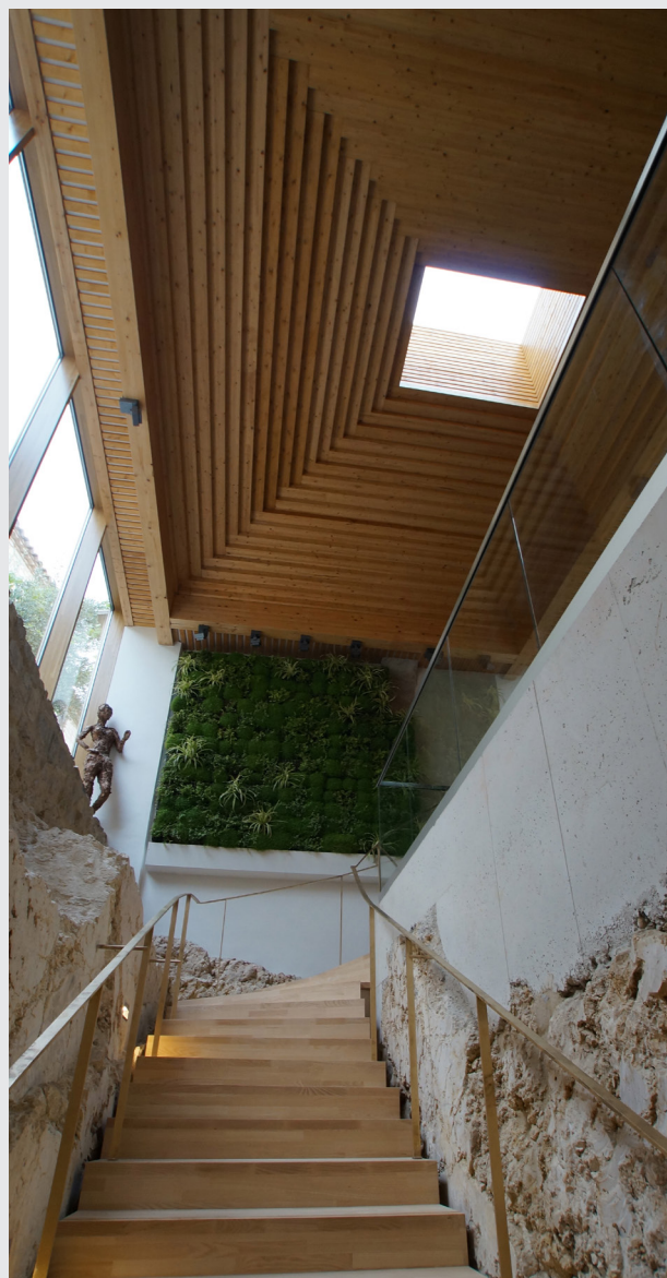
La charpente pyramidale en madriers de bois empilés du hall amène, par une ouverture zénithale, le regard vers le ciel.
