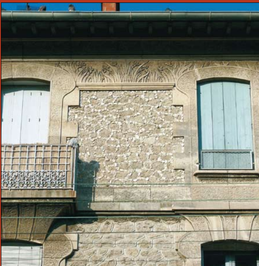
Le forget débordant protège une frise d'iris. L'appareillage différencie les étages.
