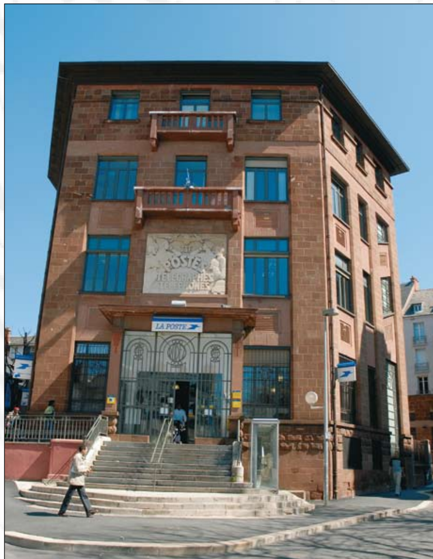
Façade principale de la poste de Rodez
