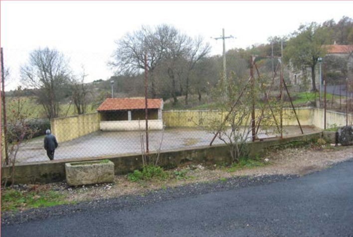
La place avant réhabilitation
