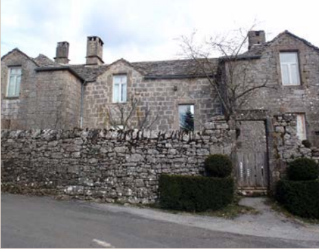
Une construction caussenarde, peu modifiée sur la commune de Campestre-et-Luc.
