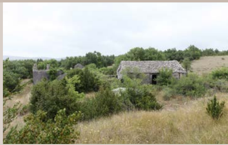
Le Mas Calmels, en ruines sur la commune du Cros. Abandonné depuis bien longtemps, sa toiture est encore en lauzes...
