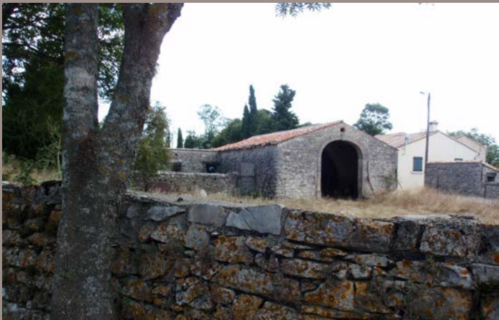
Remise agricole et bergerie à St-Maurice-Navacelles
