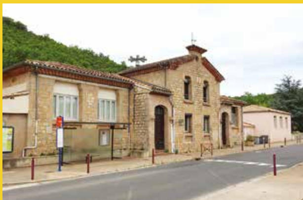
Vue de la façade «historique» de l'école construite en 1902 et d'une extension récente qui lui est accolée.
