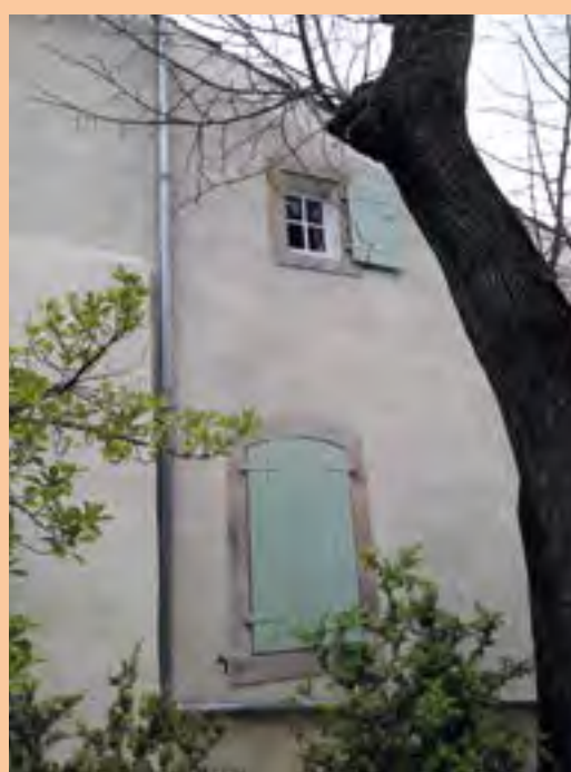
Détails des percements réalisés en façade sur jardin après travaux.
