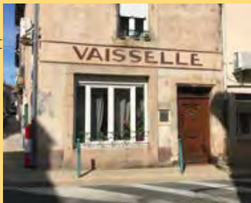
À Bessan, il existait une vraie pratique de l'enseigne peinte sur la façade. Ici, un vestige conservé.
