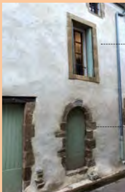
Façade sur rue après travaux
