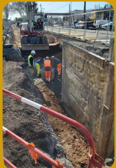
*Un détail du chantier: tranchée pour l'emplacement des réseaux © CAUE 34*
