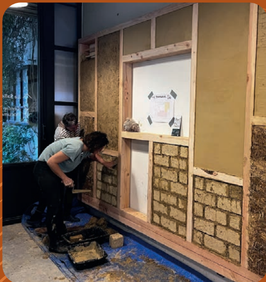
Réalisation d'un mur démonstrateur © CAUE 34
