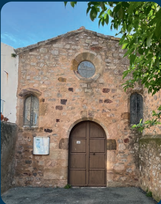
La porte de l'église – Avant © CAUE 34
