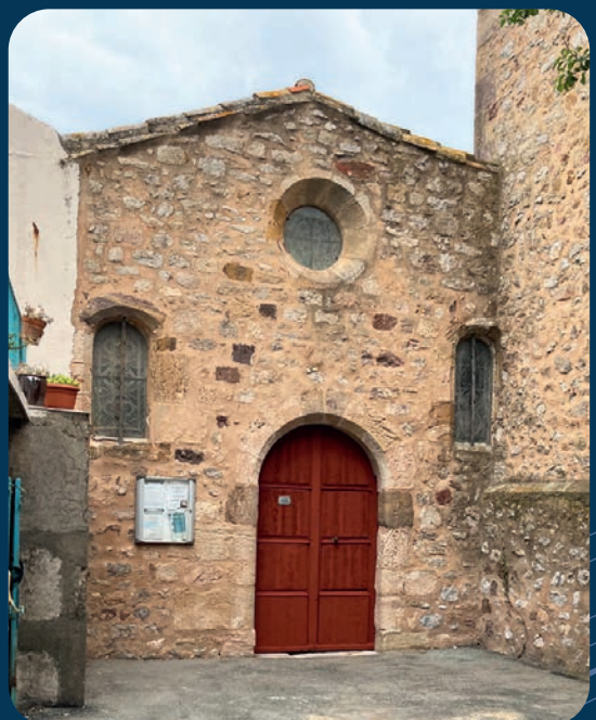
La porte de l'église – Après © CAUE 34
