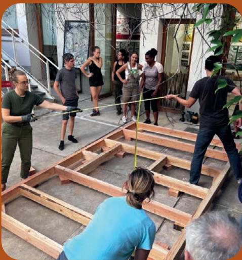
Mise en oeuvre de l'ossature bois, support du mur démonstrateur © CAUE 34
