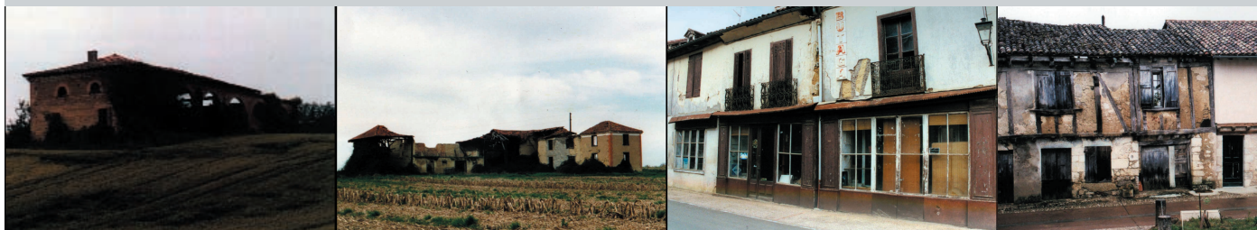
Belle maison à arcade abandonnée, Savès Ferme équerre en ruine dans l'Astarac Devanture d'un ancien commerce à Lupiac Habitat dégradé au coeur de Flamarens
