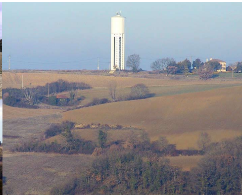
Château d'eau dans le Savès
